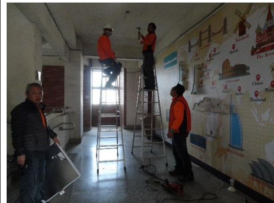
走廊更換為 LED 燈具
