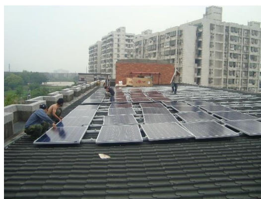
頂樓太陽能板增設
