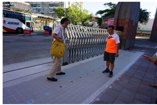
校門口排水系統改善工程
