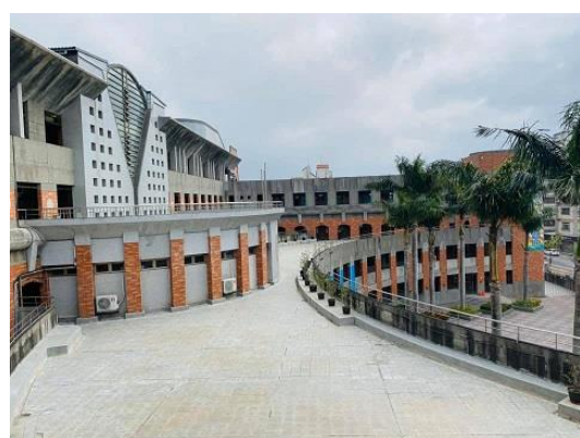
三樓平台漏水改善工程
