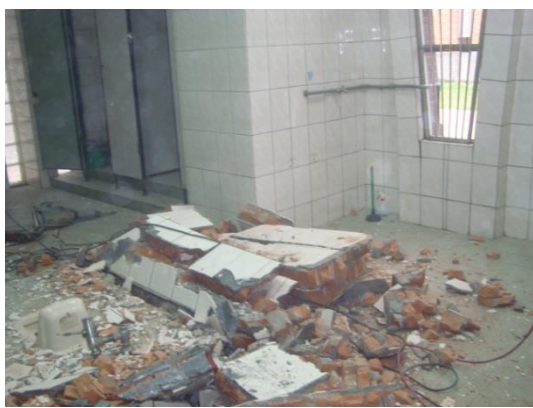
整修前：體育館老舊廁所
